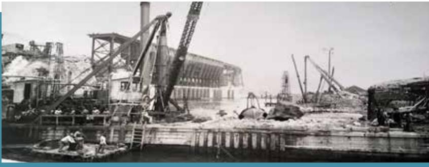
Ubicado en la IV Región de Coquimbo, en la comuna de La Higuera, Puerto Cruz Grande comenzó sus funciones en el año 1913 impulsado por la Compañía Minera del Pacífico (Cmp). El puerto fue construido en una obra que se excavó en la roca viva, con una profundidad de 14 metros, una longitud de 300 metros de largo y 70 metros de ancho.
