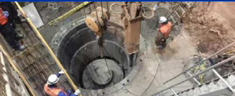
Cóncavas Chancador Primario Fuller
