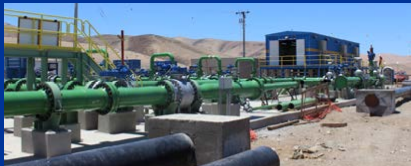
Obras Civiles, Estructuras y Piping
